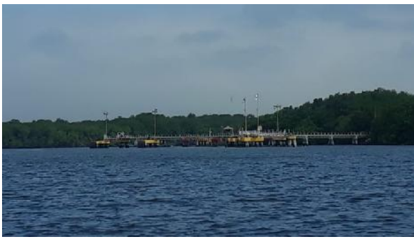
Fotografía: Muelle del Terminal de Petroecuador 3 bocas
